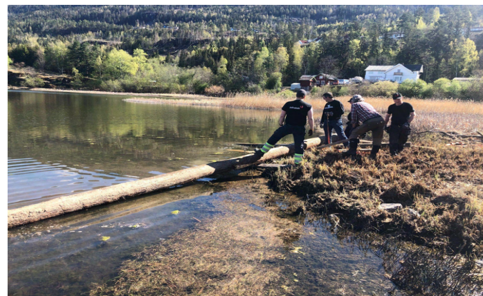
Til høyre har vi fått meginhufr ut i vannet, hvor den skal ligge til vi skal bruke den
