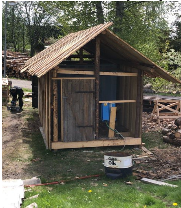
Utvidelsen av verktøy- containeren nærmer seg ferdig.
